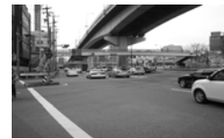
図-3 鶴舞第一歩道橋
